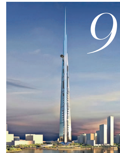
9. Самая высокая башня KINGDOM TOWER высотой в 1 км (240 этажей) строится в Саудовской Аравии, близ городка Джидда.
